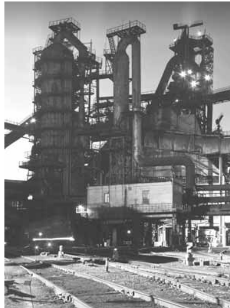
Typowe zastosowanie – wielki piec ▲
