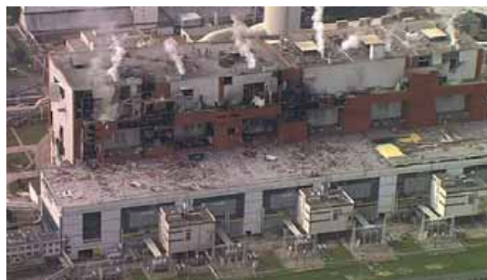
◀ Obraz zniszczeń po wybuchu pyłu zawieszonego w Elektrowni Turów – źródło:www.tvn24.pl
